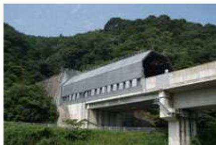
Konstruksi peredam udara termampatkan.
